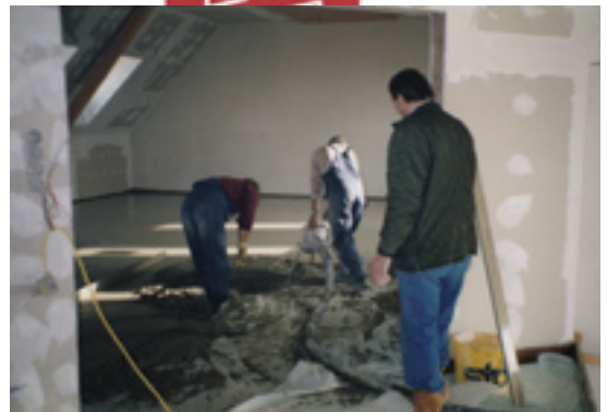
Estricharbeiten im Dachgeschoß
