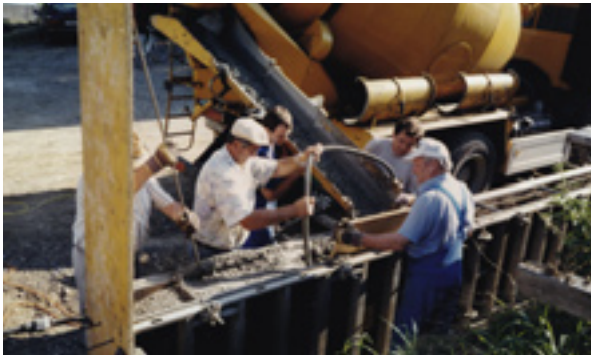
Betonieren der Gartenmauer, September 1997
