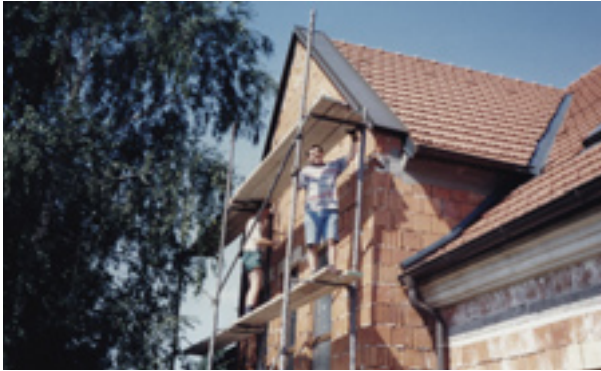
Gerüstaufbau für außen, 23. August 1997
