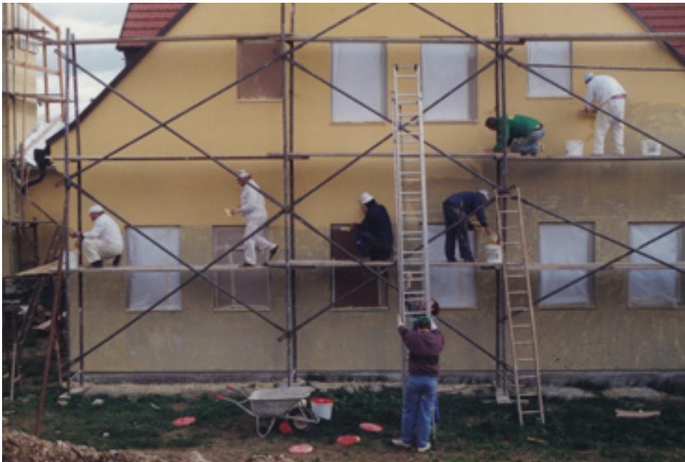
Arbeiten an der Fassade
