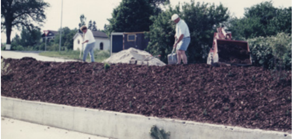
Anlegen der Böschung
