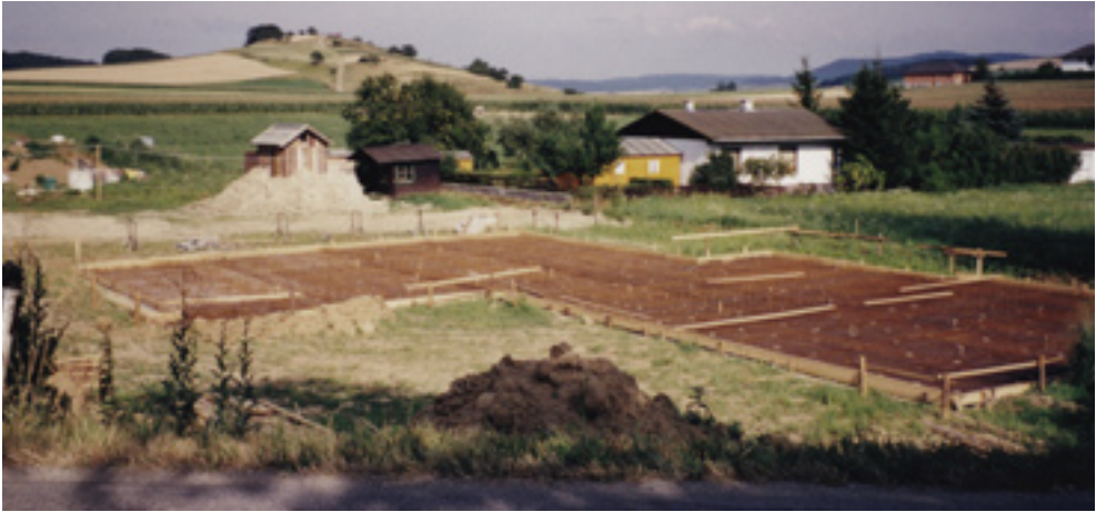
Beginn Fundament des FF-Hauses, 14. Juli 1994
